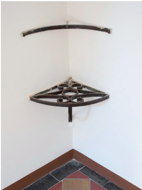
Die meist gusseiserne Konstruktion wurde früher für das Abstellen von Kohlsäcken verwendet.
